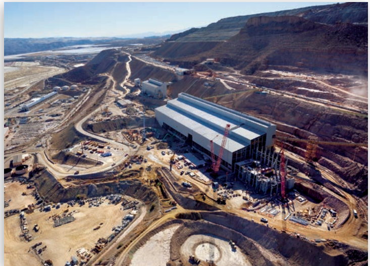
En nuestra mina de Morenci, en Arizona, estamos expandiendo la capacidad de minería y molienda para procesar minerales de sulfuro adicional. El nuevo molino utilizará considerablemente menos energía por tonelada de mineral procesado que las tecnologías anteriores.
